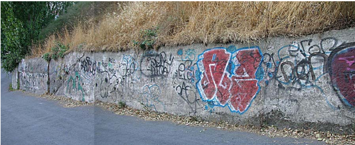
Şekil 3: Nişantaşı-“Teneke Mahallesi” sınırında grafiti duvarı, 2008 (İpek Özmen)
